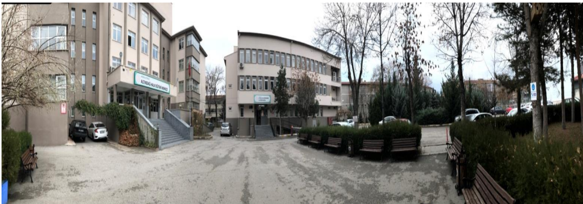
Görsel 1. Altındağ Halk Eğitimi Merkezi Binası
