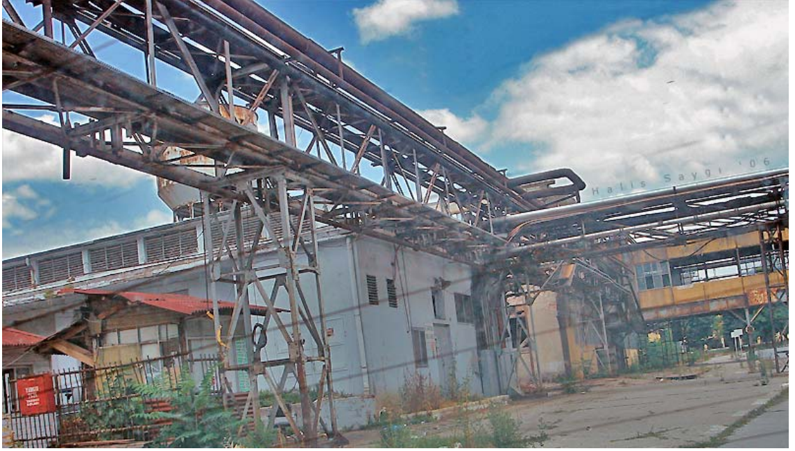
Şekil 3.21 Mevcut yapılara ait bağlantı kanalları (Orijinal 2006)
