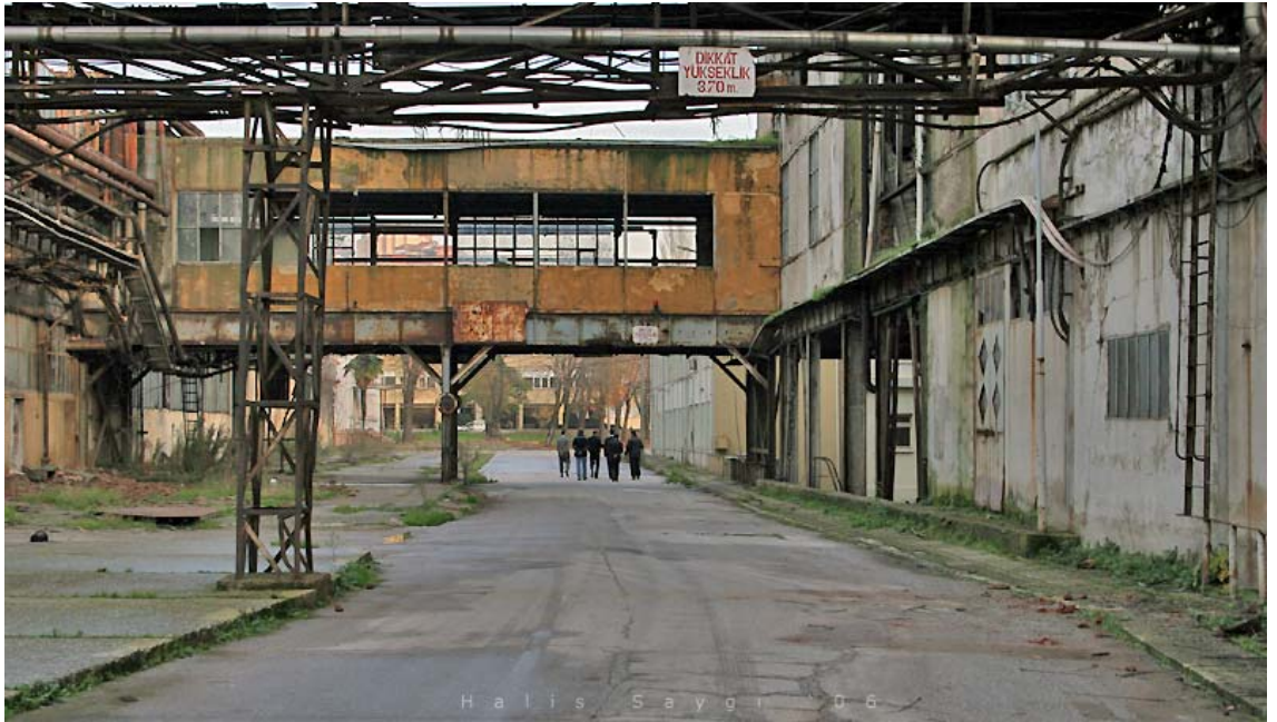
Şekil 3.20 Mevcut yapılara ait bağlantı kanalları (Orijinal 2006)
