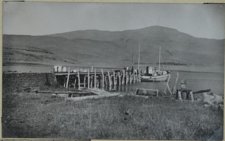
030 10 120 119 Ertis iskelesinin görünüşü
