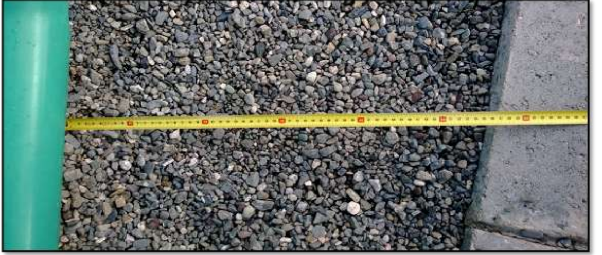
Şekil 4.52 Çıkış ve kenar bordür arasındaki mesafe (550mm)
