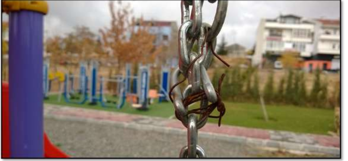
Şekil 4.60 Tehlikeli çıkıntı yaratan ve bütünlüğü bozan montaj şekli
