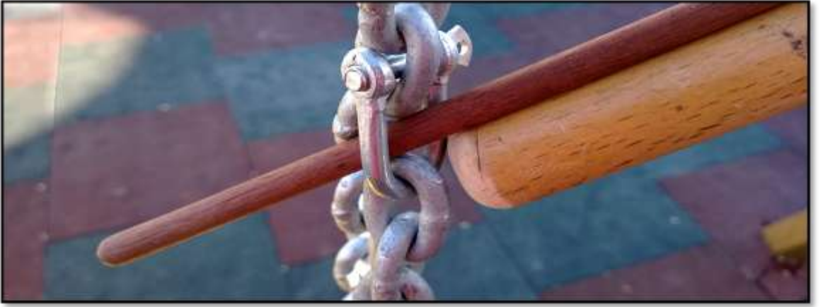
Şekil 4.4 Keskin çıkıntı ve parmak yakalama
