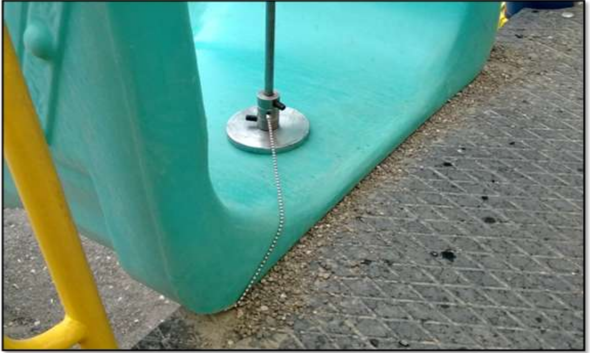
Şekil 4.41 Giysi ve saç yakalama
