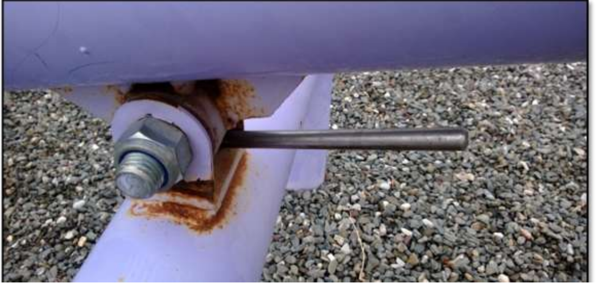
Şekil 4.68 Sıkıştırma etkisi
