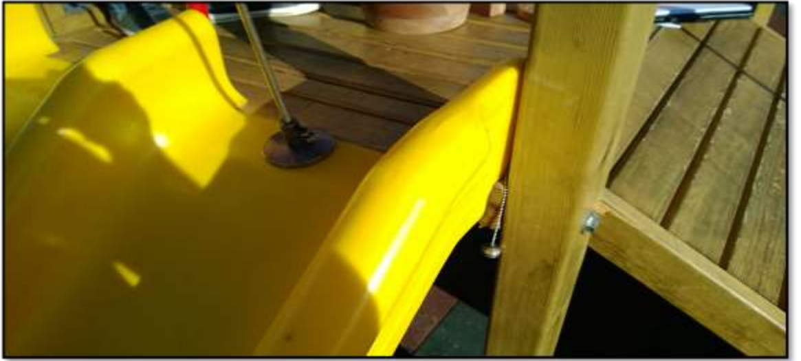
Şekil 4.16 Giysi ve saç yakalama
