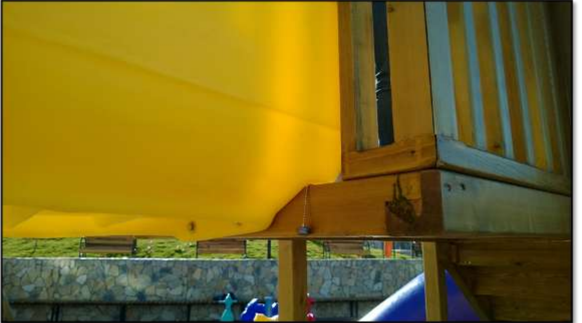
Şekil 4.22 Giysi ve saç yakalama
