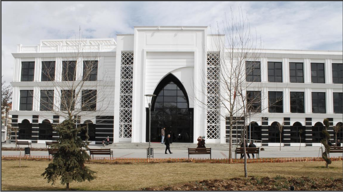
Fotoğraf 71: Konya İl Halk Kütüphanesi Binası
