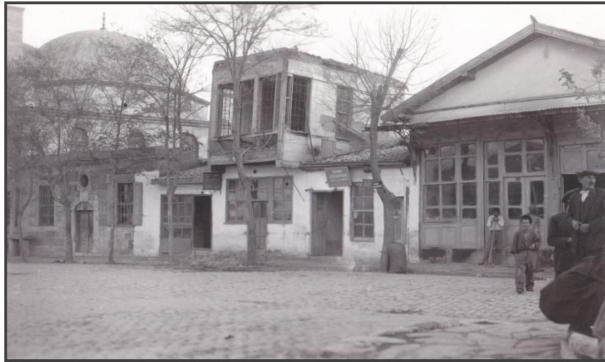
Fotoğraf 45: Yıkılan Muvakkithane ve Türbe Hamamı
