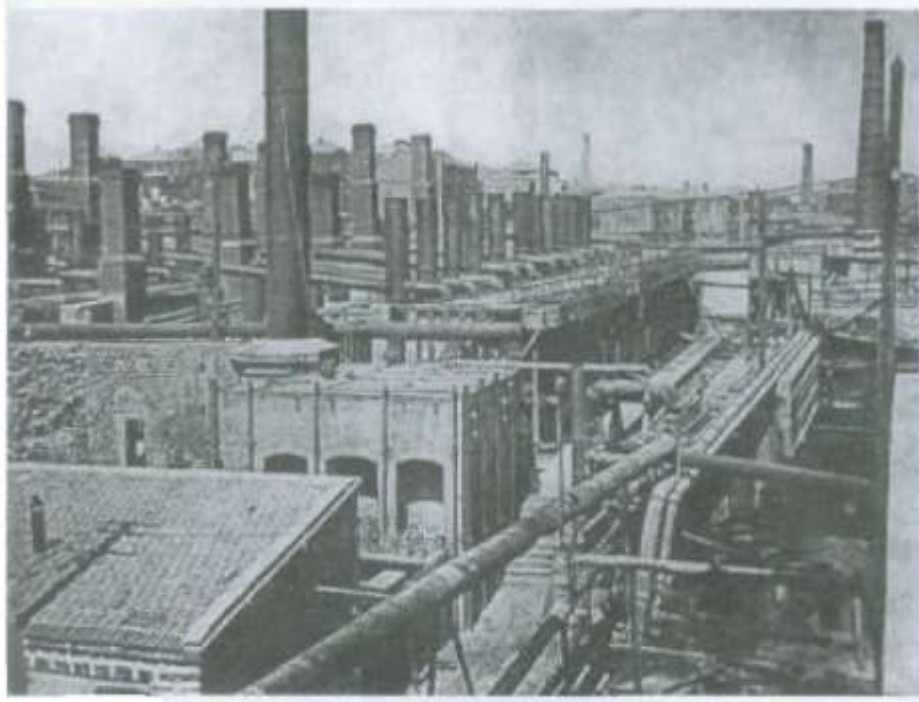
Ağsəhərdə "Qırmızı ulduz" elektrik stansiyası (1925)
