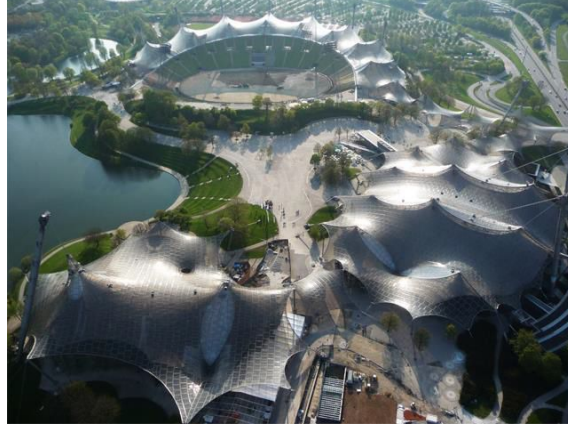
Şekil 1.3 Frei Otto tarafından tasarlanan Münih Olimpik Parkındaki spor tesislerinin çatısı
