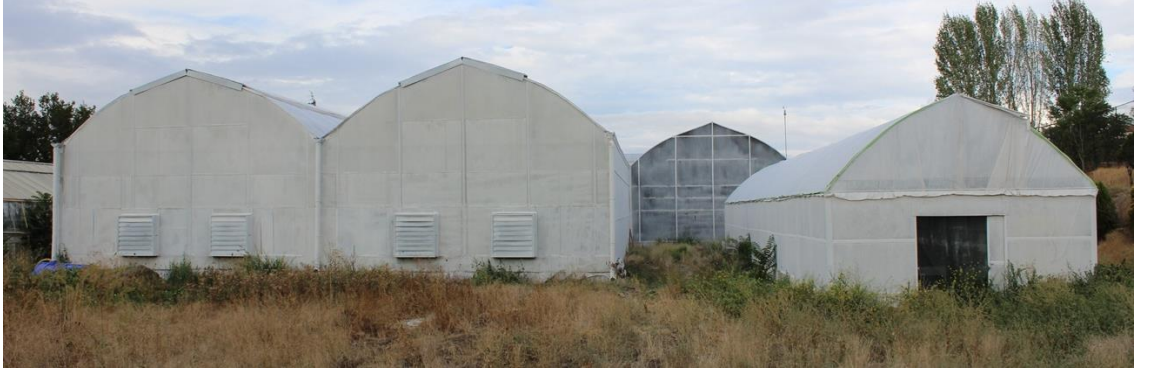
Şekil 3.1 Çalışmaların yürütüldüğü ıslahı seralarından görünüm
