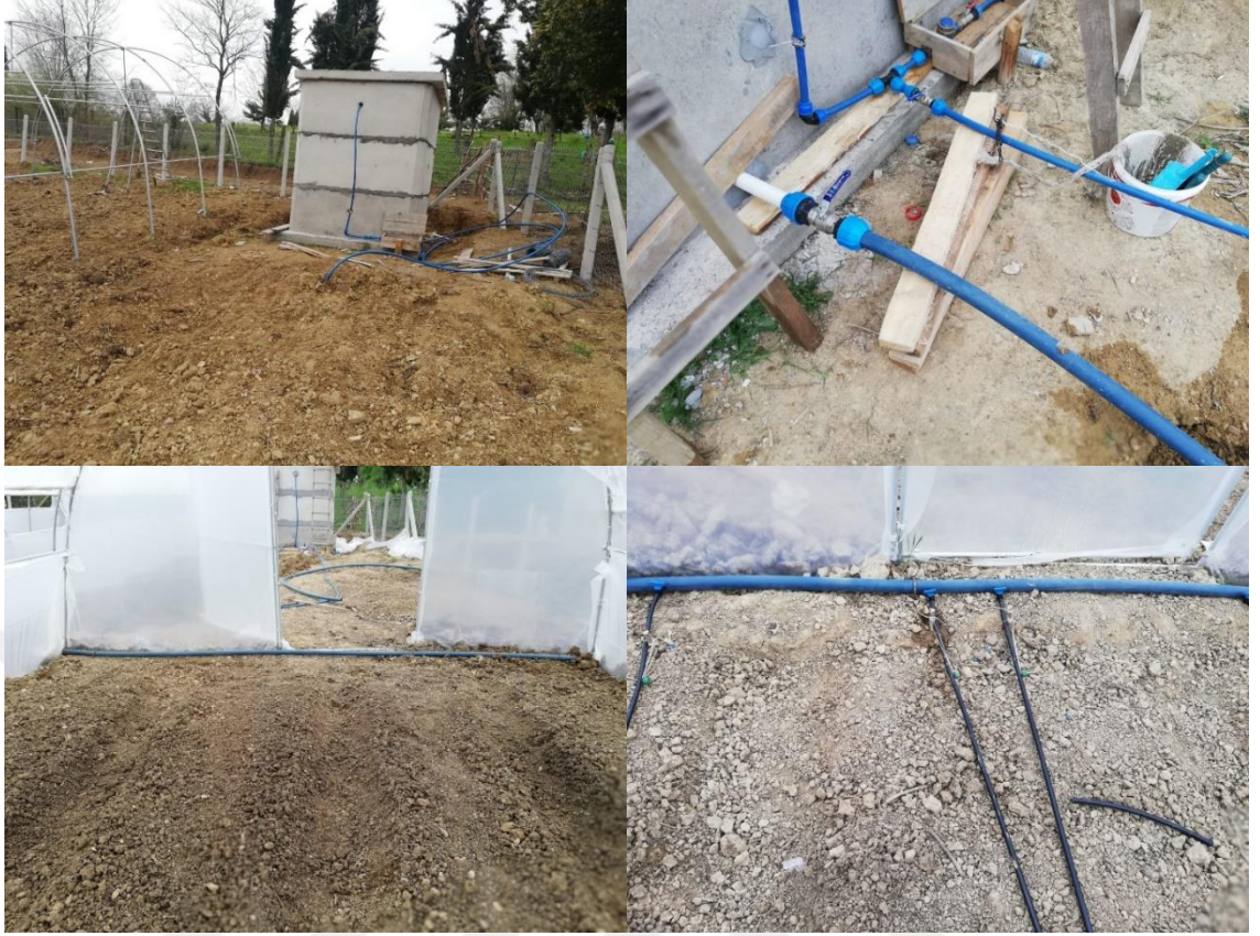
Şekil 3.6 Su deposu ve sulama sistemi kurulum görüntüleri
