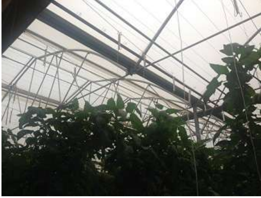
Şekil 3.13 Gotik çatı örneği
