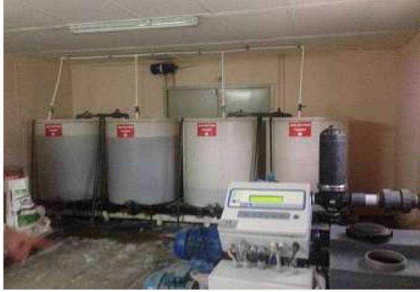
Şekil 3.10 Gübre ve sulama entegre sistemi(otomasyonlu)
