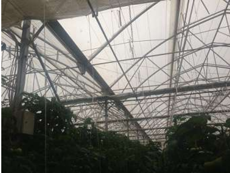
Şekil 3.18 Çatı kafes sistemi
