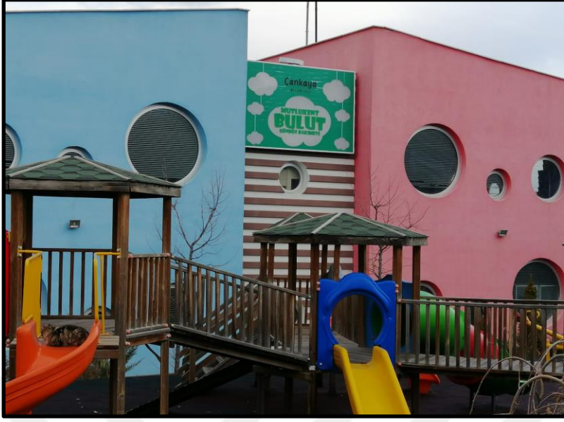
Mutlukent Bulut Gündüz Bakım Evi
