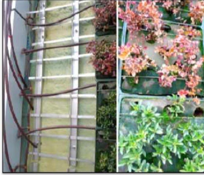
Şekil 2.36 Dikey bahçelerde sulama sistemi örneği ( www.healinggardenproject.blogspot.com.tr 2013)
