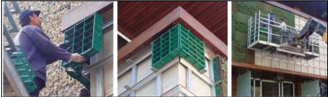
Şekil 2.15 Panel sistem ile dikey bahçe uygulaması (www.pemagarden.com 2013)
