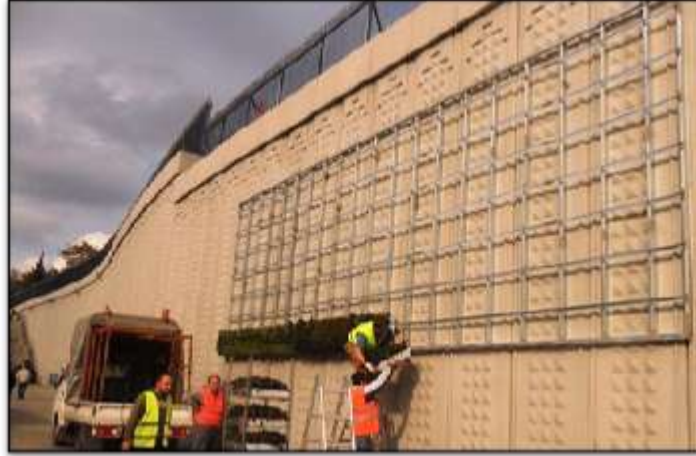
Şekil 2.18 Panel sistem ile düz olmayan bir yüzeye montaj (Fidesgrup 2012)
