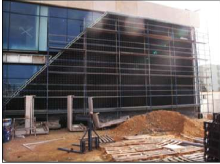
Şekil 4.47 Antalya Erasta AVM- Modüler sistem dikey bahçe konstrüksiyonu (Elinç vd. 2013)
