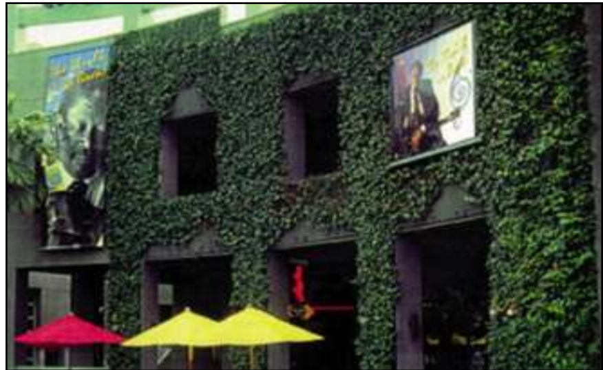
Şekil 2.2 Universal CityWalk Binası - Kaliforniya (www.greenscreen.com 2012)
