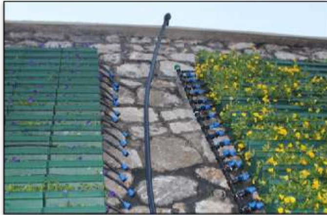
Şekil 4.51 Konya Yolu yařayan duvar uygulaması sulama sistemi - Ankara-Trkiye (Orjinal 2013)
