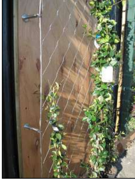
Şekil 2.13 Paslanmaz çelik tel kafes ile oluşturulan yeşil cephe örneği ( www.thegardenglow.com 2014)
