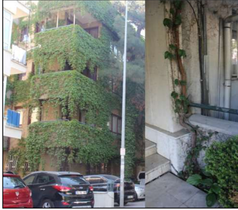
Şekil 2.10 Toprağa dikim yolu ile oluşturulan yeşil cephe örneği – Ankara (Orjinal 2013)
