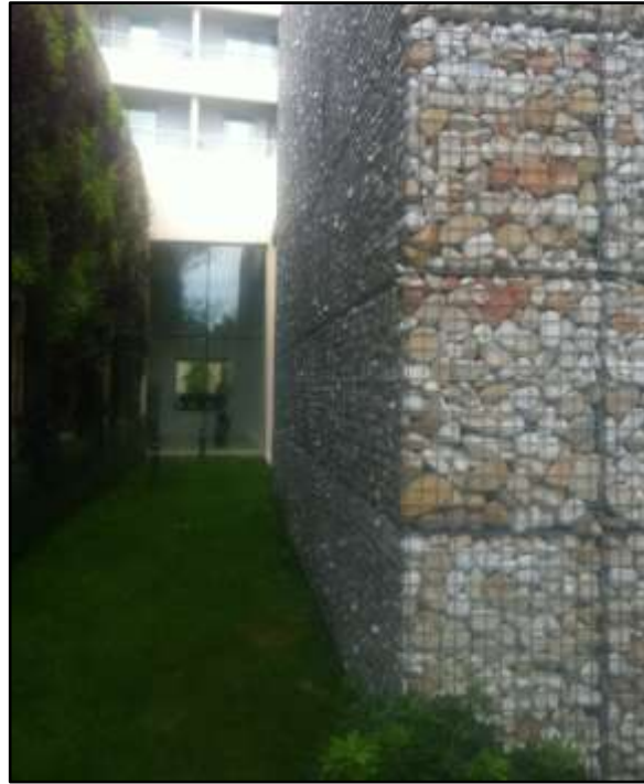
Şekil 2.30 Sentido Zeynep Golf Resort Otel Gabion duvar örneğı – Antalya-Türkiye (Orjinal 2013)
