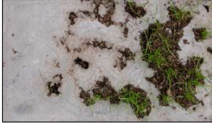
Şekil 2.9 Organik beton yüzey üzerinde oluşan doğal bitki duvarı ( http://whatwasilookingfor.blogspot.com.tr/ 2013)
