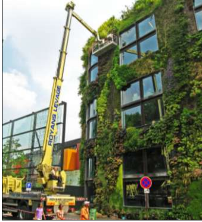
Şekil 4.33 Quai Branly Müzesi – Yaşayan duvar sistemi bakım çalışması (Anonymous 2012)
