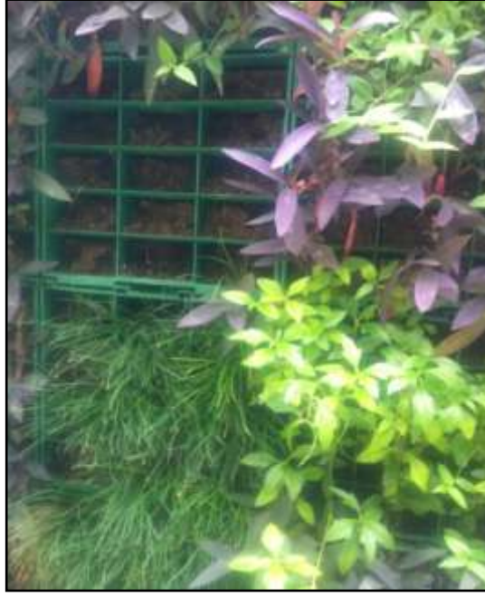
Şekil 2.14 Panel sistem yaşayan duvar örneği - Zeynep Resort Otel (Orjinal 2013)
