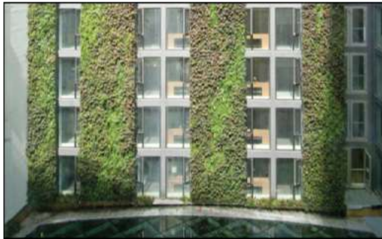
Şekil 4.27 Mint Otel dış avlu cephesi yaşayan duvar sistemi (Anonymous 2014c)
