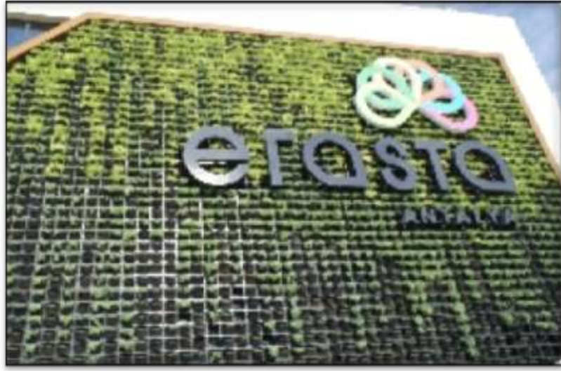
Şekil 4.13 Erasta Alışveriş Merkezi yaşayan duvar sistemi – Antalya- Türkiye (www.duwardabahce.com 2014)
