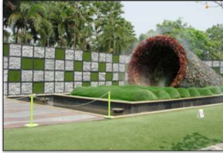
řekil 2.31 Tayland EXPO alanı gabion sistem ve dikey bah e  rneđi – Tayland (Erken 2011)
