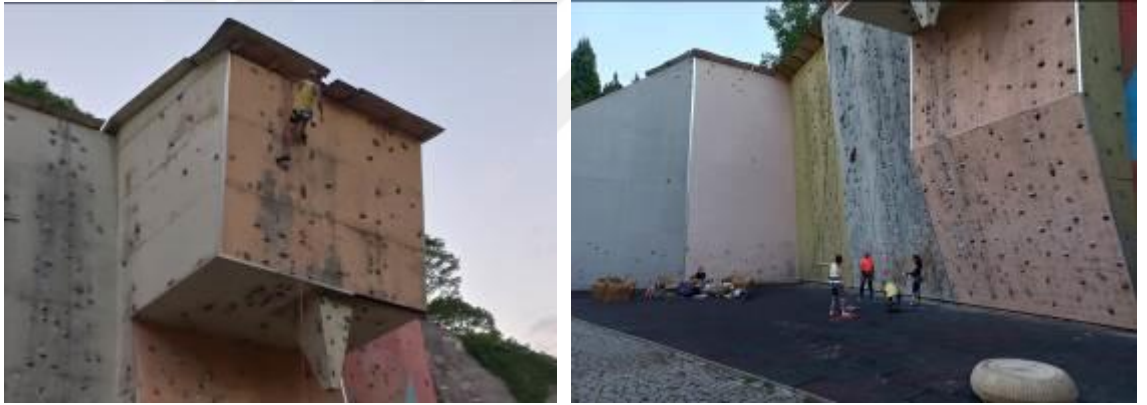
Şekil 4.28 Tırmanma duvarı (Orijinal 2022)
