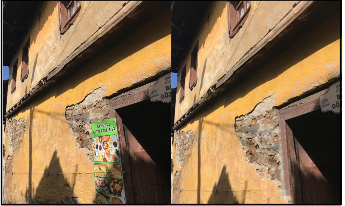
Şekil 5.17 Bina cephesinde kullanılan afişlerin kaldırılması önerilmiştir (Orijinal 2020)
