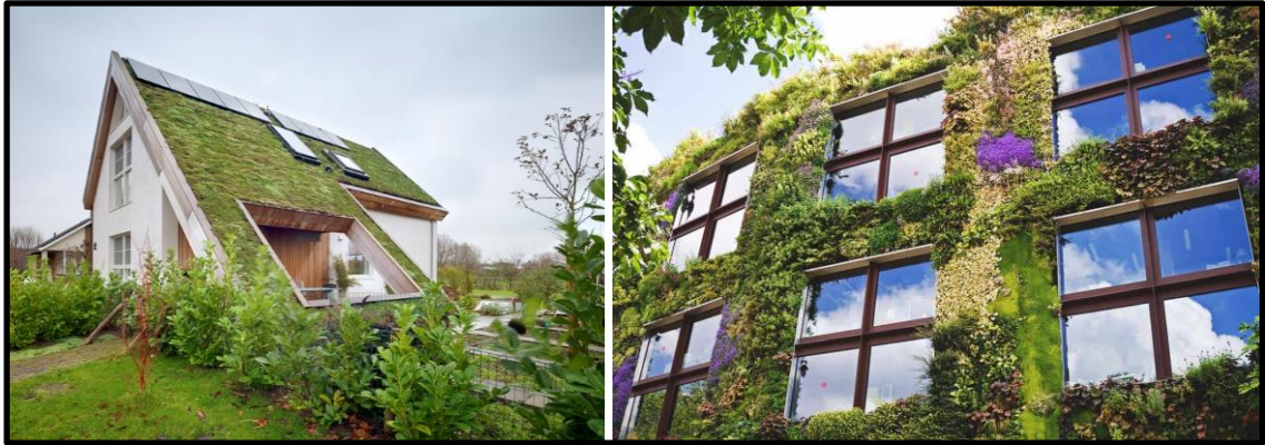
Şekil 2.34 Yeşil çatı ve duvar uygulamaları (Anonymous 2022c) (Anonymous 2022d)
