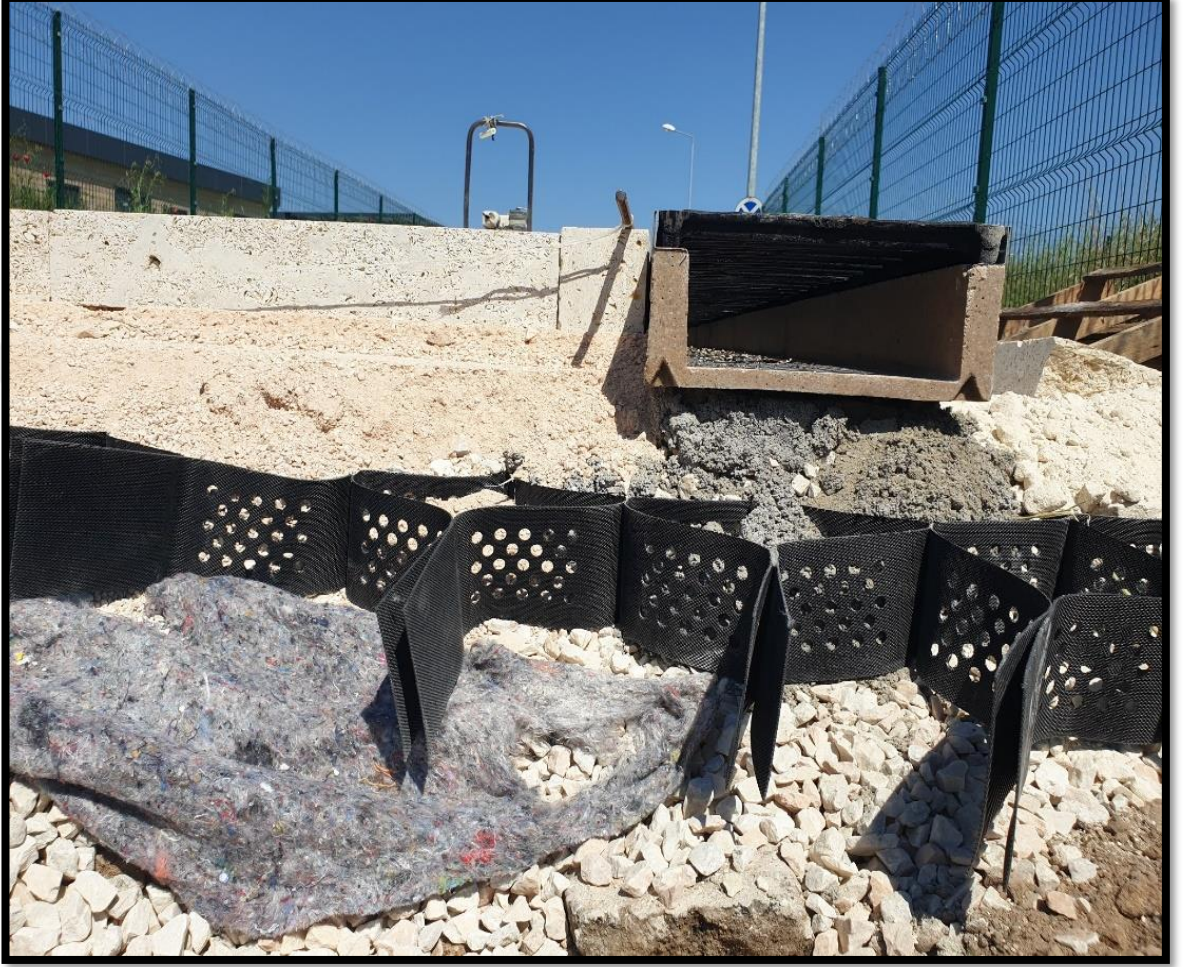
Şekil 2.33 Geogrid uygulaması (Orijinal 2022)
