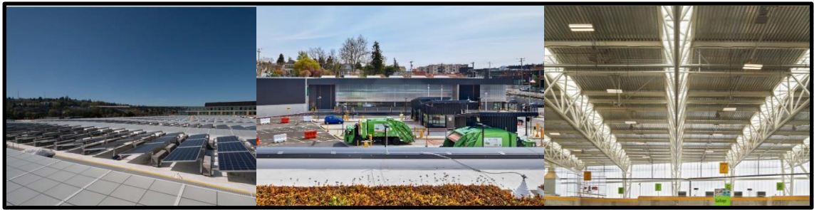
Şekil 2.9 Kuzey Transfer İstasyonu ve fotovoltaiik, doğal aydınlatma pencereleri (AIA 2021)
