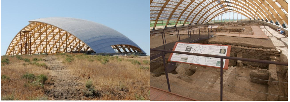
Şekil 2.26 Çelik ve polikarbon malzemeden yapılmış koruyucu çatı detayı (Çatalhöyük arkeolojik alanı) (Quinlan 2010)
