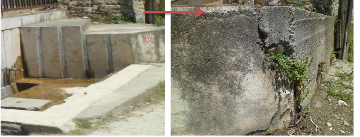
Şekil 5.6 Üzeri beton ile kaplanmış basamak ve cephesi mermer ile kaplanmış çeşme duvarı (Orijinal 2013)
