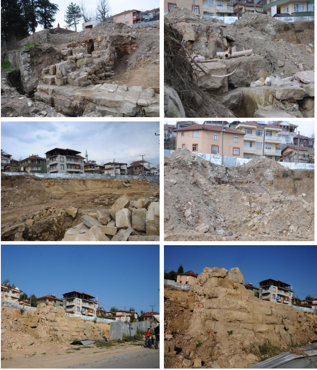
Şekil 4.26 Hamam alanından görünüm (Şimşek 2010)
