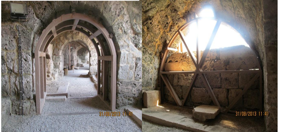
Şekil 2.22 Side Antik Kenti tiyatro seyirci giriři tonozlarında yapılan sağlamlaştırma çalışmaları (Orişinal 2013)
