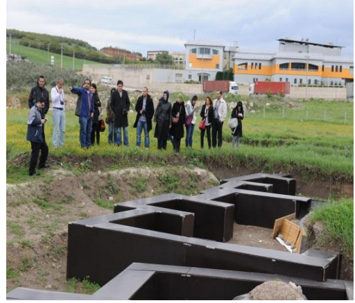
Şekil 2.125 Arkeolojik yapı kalıntılarının ahşap ve plywood kalıba alınarak korunması
