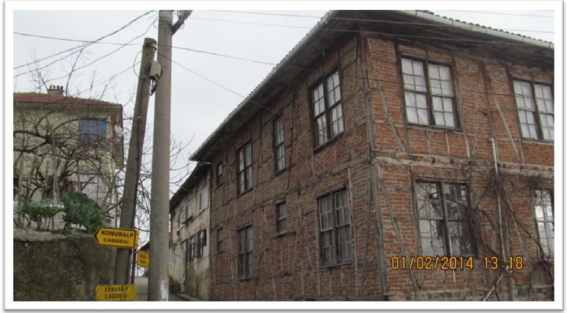
Şekil 4.62 Başol Sokak 1745 nolu parselde bulunan tescilli sivil mimari örneği, 1746-1745 nolu parsellerdeki tescilli geleneksel konutlar (Orijinal 2014)
