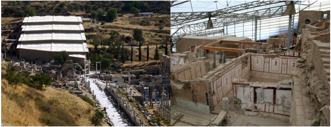
Şekil 2.25 Efes yamaç evler koruyucu çatı yapıları (Anonim 2013 k)
