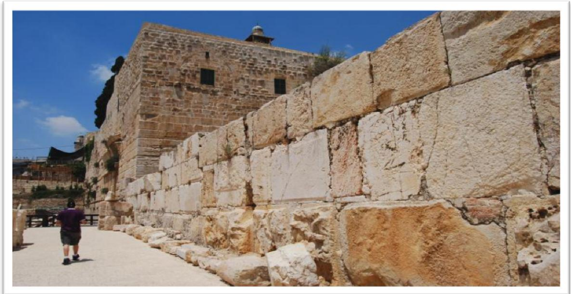
Şekil 2.68 Emevi Sarayı'nın güney duvarı (Anonymous 2014e)
