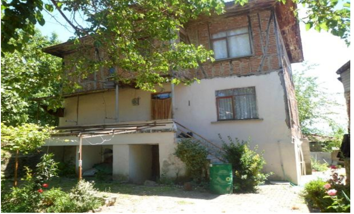
Şekil 4.52 Dış cephe sıva kaplama yapılan geleneksel konut örnekleri (Orişinal 2013)
