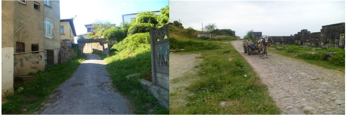
Şekil 4.38 Atlı Kapı Sokak'taki geleneksel taş üzeri asfalt kaplamalı yol, Antik tiyatro orkestra alanı geleneksel taş kaplama üzeri asfalt kaplamalı yol (Orijinal 2013)
