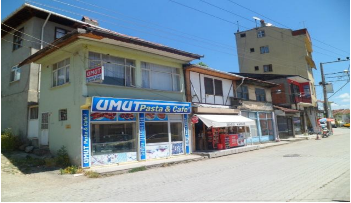
Şekil 4.50 Çarşıiçi Caddesi üzerindeki betonarme yapılar (Orijinal 2013)
