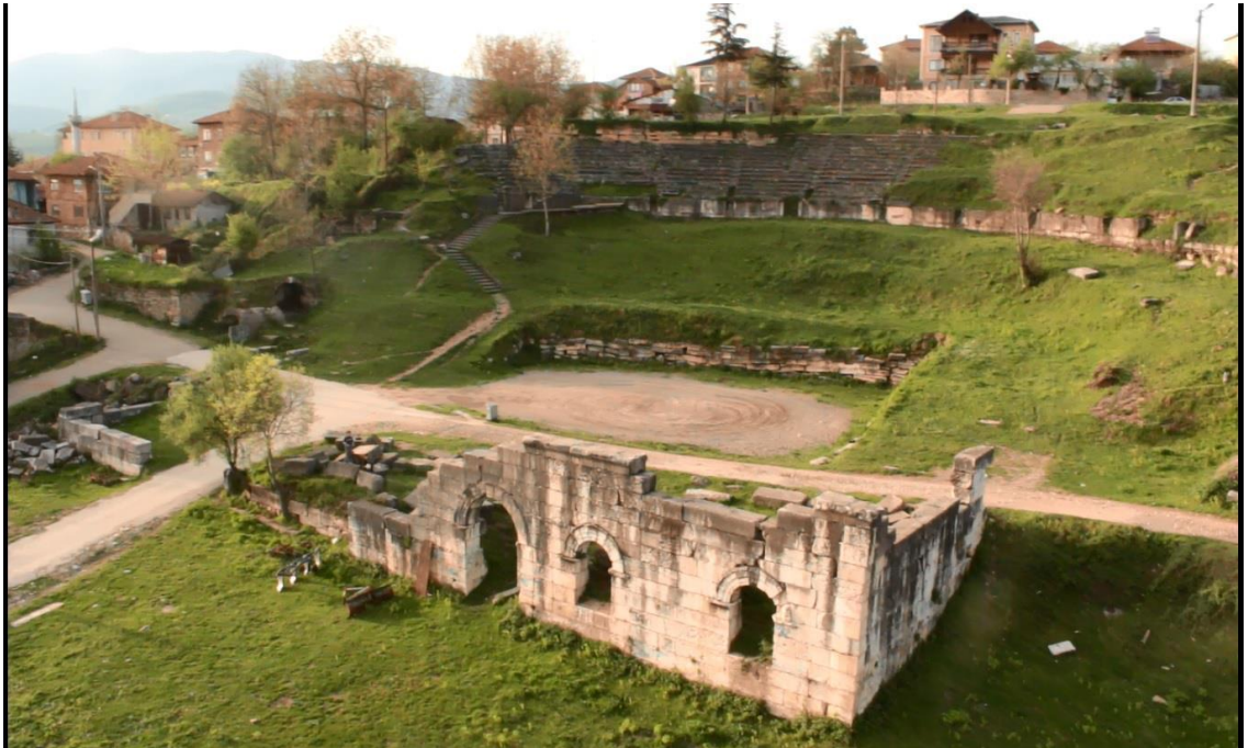
Şekil 4.15 Kazı çalışmaları öncesi tiyatro ve sahne binası görünüm (Orijinal 2013)
