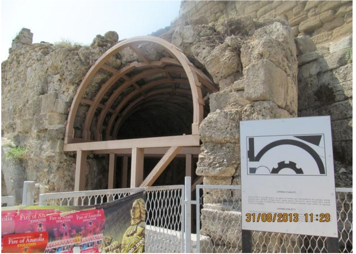
Şekil 2.21 Side Antik Kenti Latrina (tuvalet) yapısı taşıyıcı sistem sağlamlaştırma örneği (Orişinal 2013)
