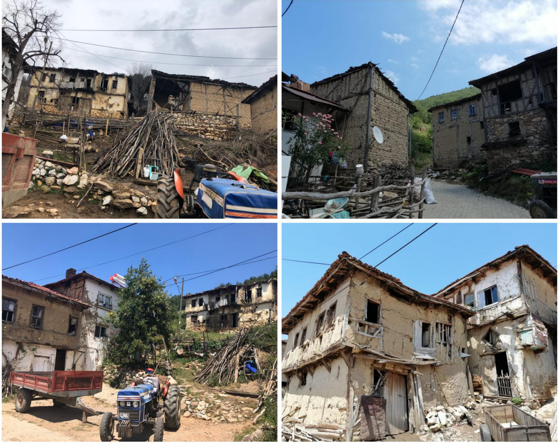
Şekil 4.83 Sansarak Köyü'ndeki bakımsız yapılar (Orijinal 2021)
