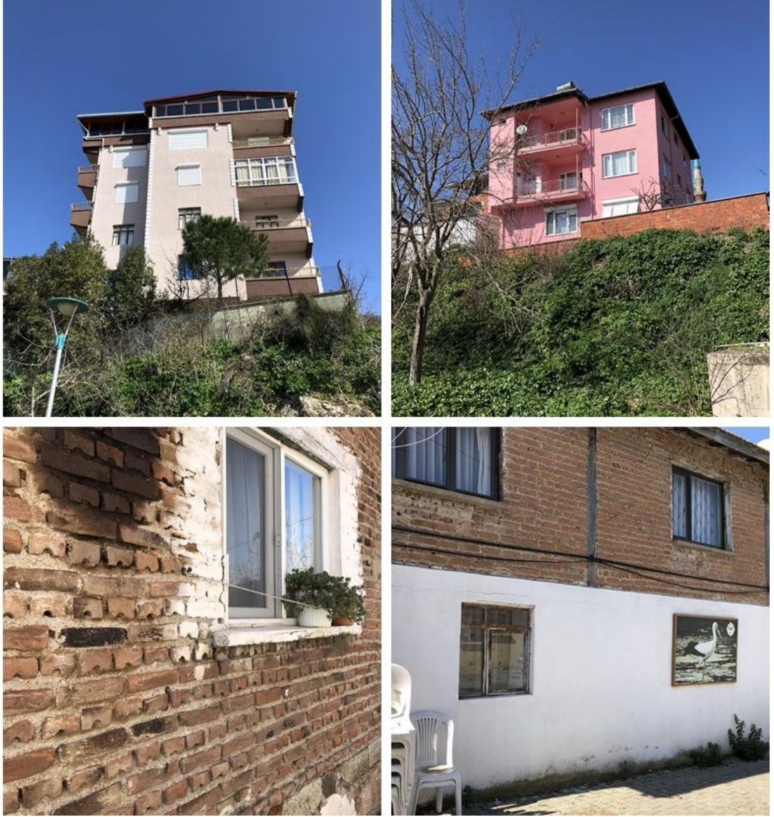
Şekil 4.15 Eskikaraağaç Köyü’ndeki yapı tipleri (Orijinal 2019)
