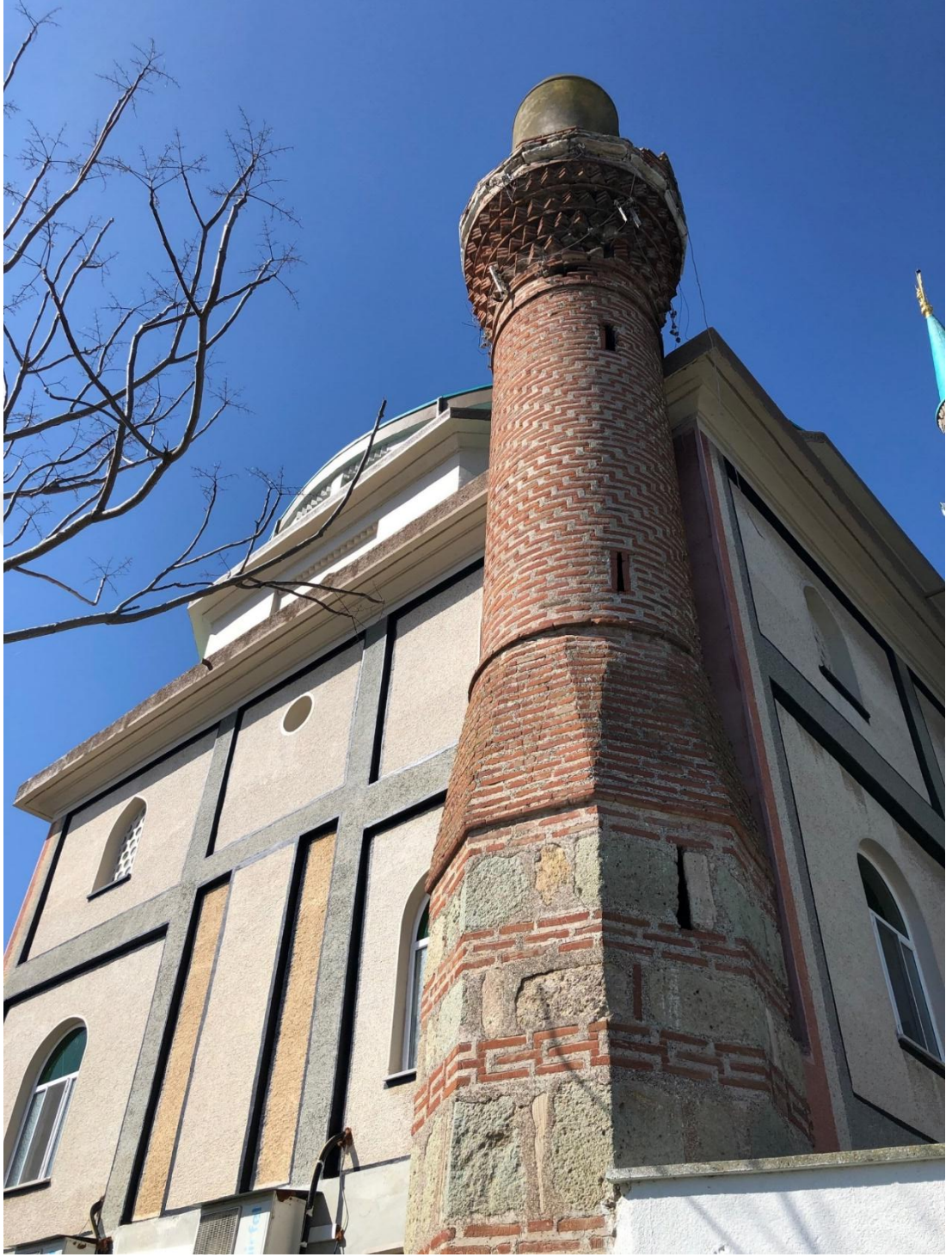
Şekil 4.19 Eski Karaağaç Camii'nin eski minaresi (Orijinal 2019)
