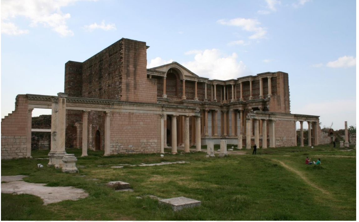
Şekil 2. 19 Hamam – Gimnazyum Kompleksi, Sardis. Eksik olan kısımlar, özgün malzemeden farklı olarak tuğla ile tamamlanarak bütünlenmiştir (Orijinal 2015).
