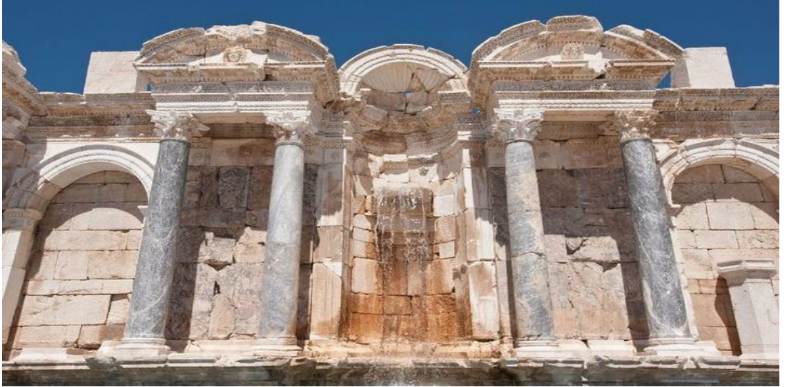
Şekil 2. 18 Antoninler Çeşmesi, Sagalassos – Burdur. Dağınık halde bulunan elemanlar birleştirilmiş ve eksik parçalar yeni taş malzeme ile tamamlanarak bütünleme yapılmıştır (Zeyveli 2010).
