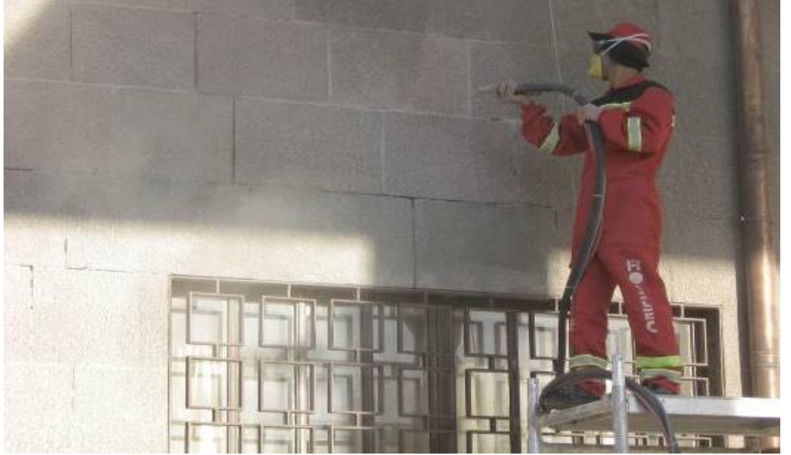
Şekil 2. 13 Kontrollü kumlama uygulaması (Ka.Ba 2006)
