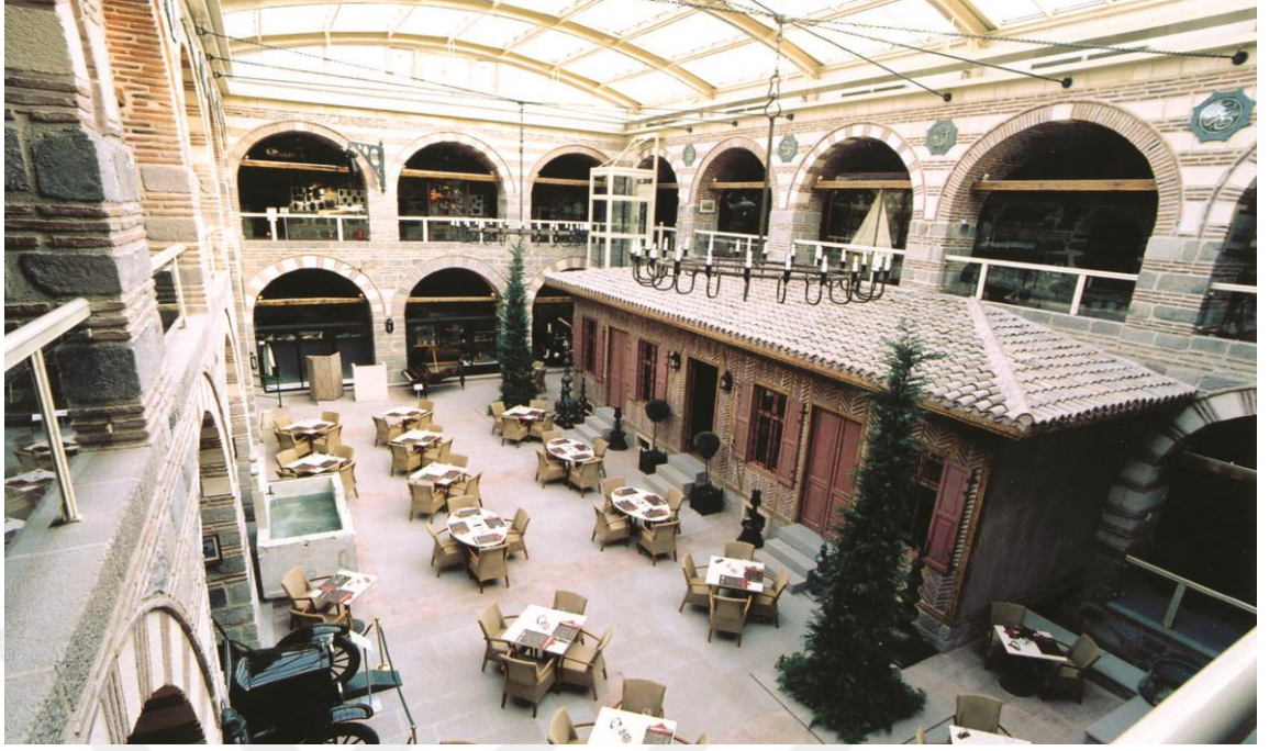
Şekil 2. 22 Çağdaş ek uygulama örneği olarak Çengelhan avlusunda yer alan tuğla örgülü, kiremit çatılı dükkan mekanı ve avlu üzerindeki çelik taşıyıcılı üst örtü (Ka.Ba 2007)
