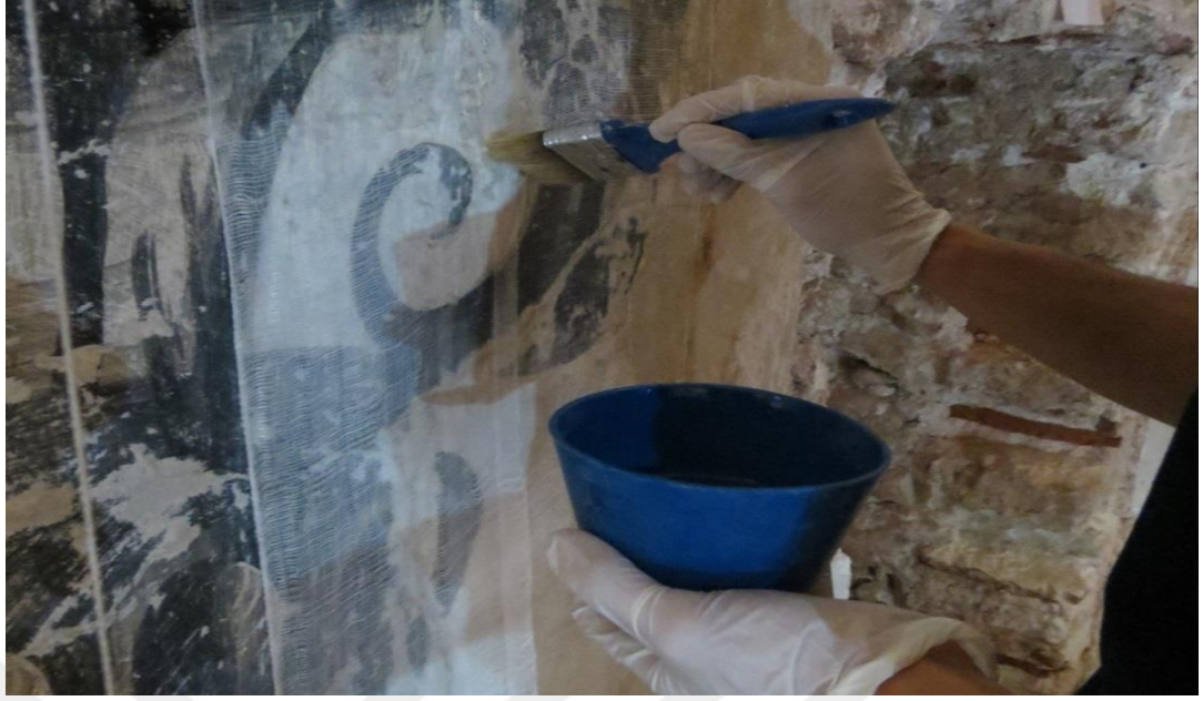
Şekil 2. 14 Sağlamaştırma amacıyla yapılan yüzeyleme uygulaması (Ka.Ba 2015).
