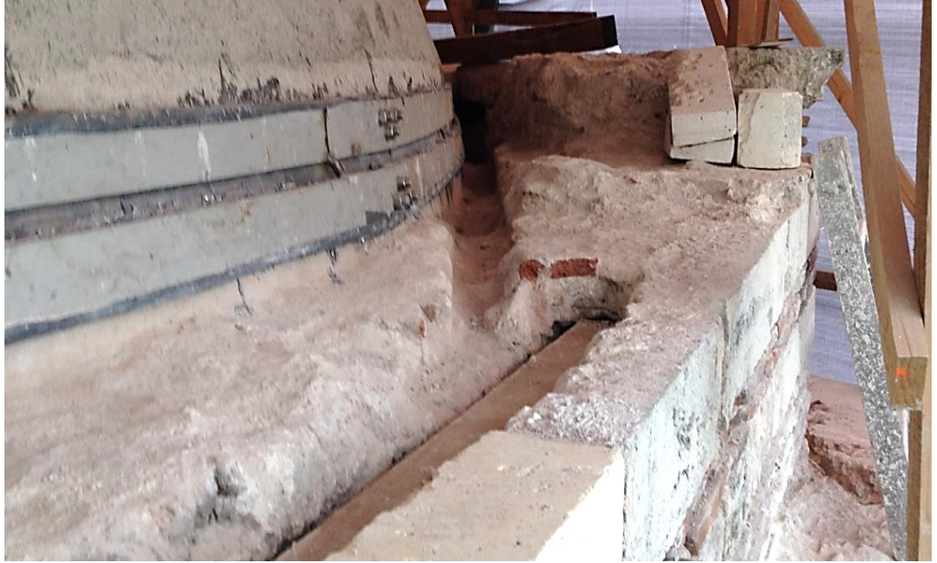
Şekil 2. 16 Kubbe kasnağında güçlendirme uygulaması (Ka.Ba 2015).
