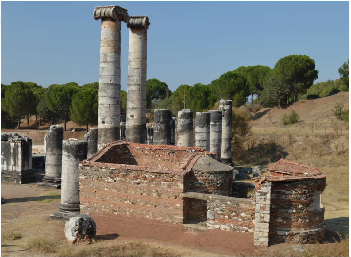
Şekil 4. 22 M Kilisesi Güney görünüşü (Orişinal 2018)
