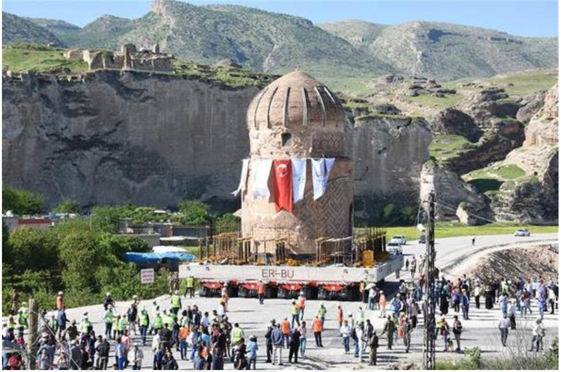
Şekil 2. 21 Hasankeyf - Zeynel Bey Türbesi taşıma çalışmaları (www.hurriyet.com.tr 2017)
