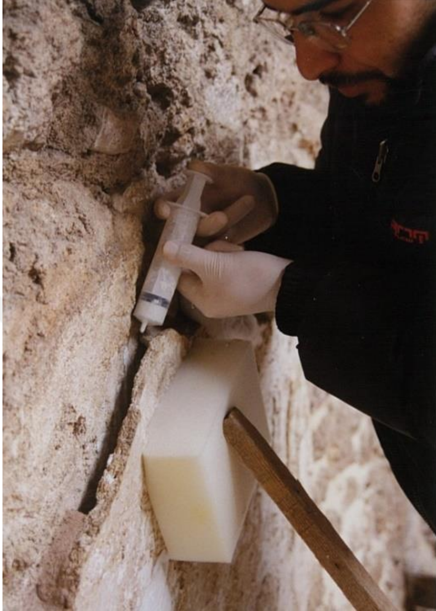
Şekil 2. 15 Enjeksiyon yöntemi ile duvar resmi sağlamlaştırma çalışması (Orijinal 2006).
