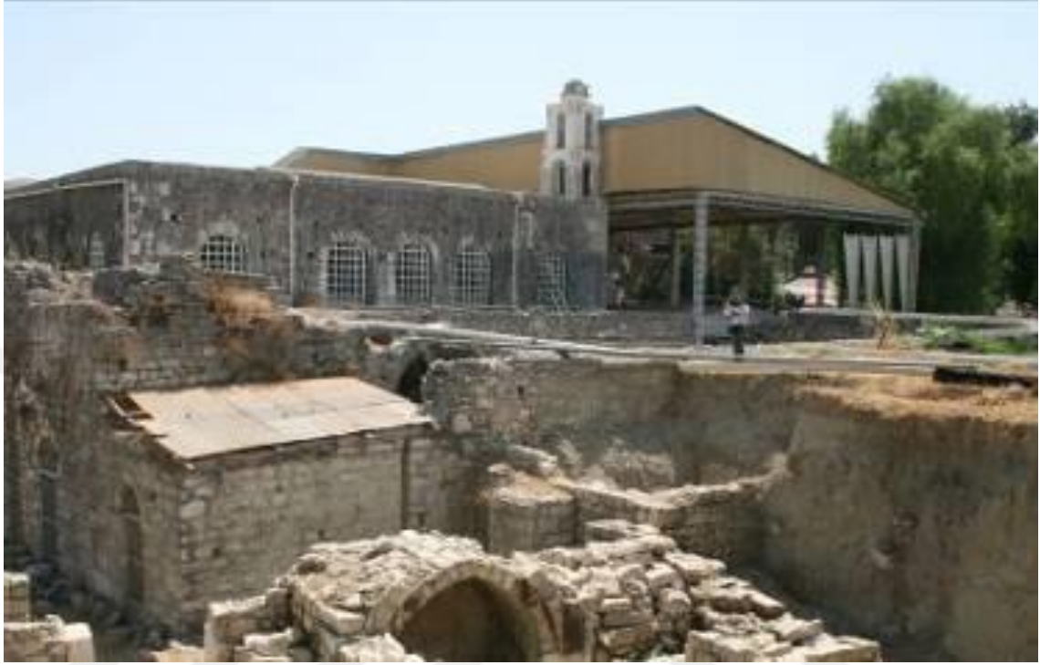
Şekil 2. 11 1860'lı yıllarda, Demre Aziz Nikolaos Kilisesi'nin çatısı düzleştirilip, pencere şebekeleri inşa edilmiş, 1990'lı yıllarda da Güneydoğu cephesinde bulunan çelik çatılı üst örtü eklenmiştir (Orijinal 2010)
