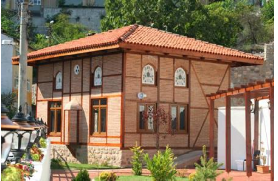
Şekil 2. 20 Portakal Hafız Mescidi, İzmit. Osmanlı Dönemine tarihlenen yapı aslına uygun detayda yeniden yapılmıştır (www.cekulvakfi.org.tr, 2009)
