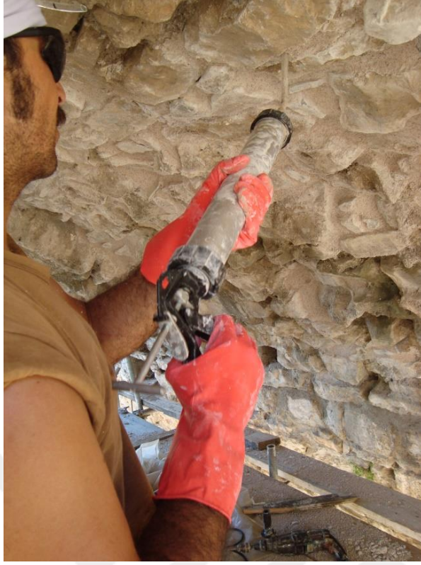
Şekil 2. 17 Enjeksiyon yöntemi ile duvar sağlamlaştırma çalışması (Türk 2007).
