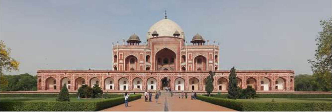
Fotoğraf 17: Türbenin Batı cephesi 185
