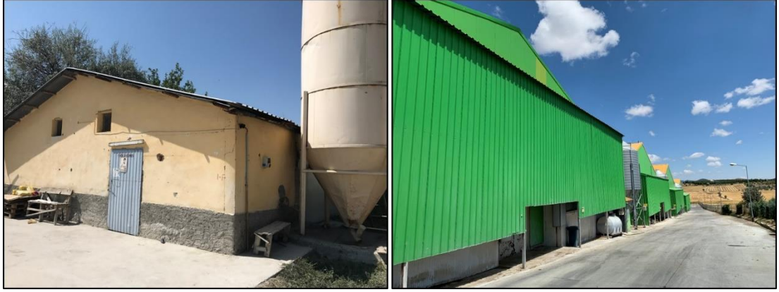
Şekil 3.50. Çalışma içerisinde ziyaret edilen Beton ve Panel kümeslerden örnekler.
