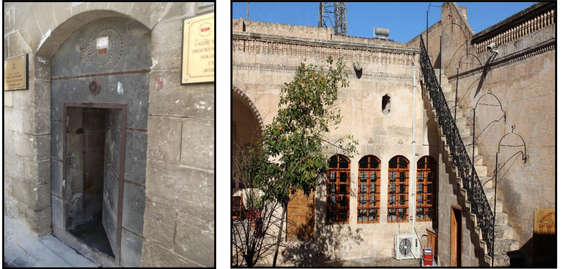
Şekil 4.102 Kapı ve korkuluklarda metal malzeme kullanımı (Orijinal 2013)
