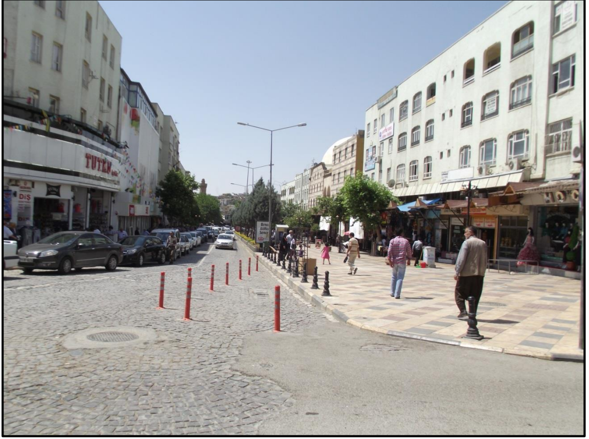
Şekil 5.24 Sarayönü Caddesi'nde bulunan geçirimli ve geçirimsiz (asfalt) yüzey (Orijinal 2013)
