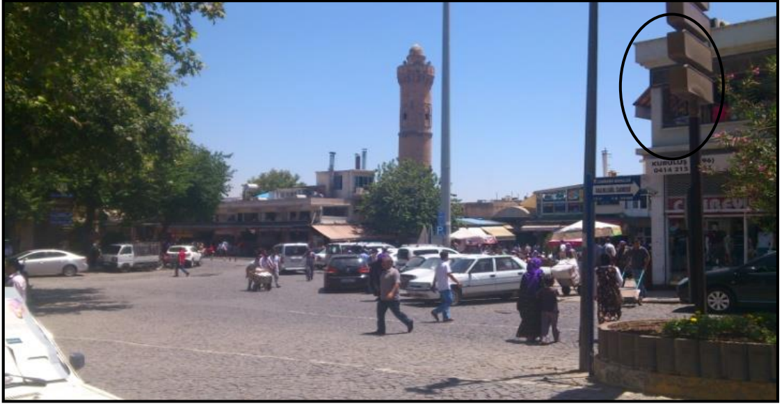
Şekil 5.5 Haşimiye Meydanı’ndaki geleneksel dokuyu bozan yapılar (Orijinal 2014)
