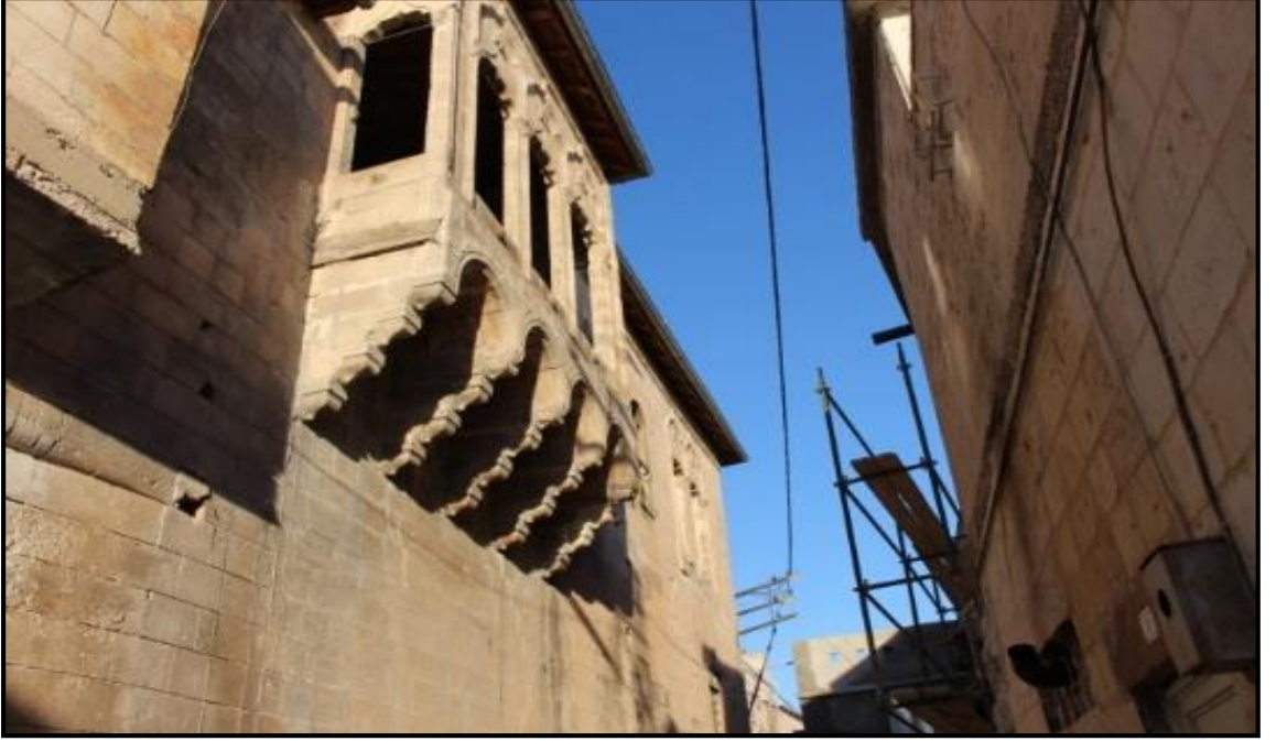
Şekil 4.50 Akyüzler Evi'nin sokaktan görünümü (Orijinal 2013)
