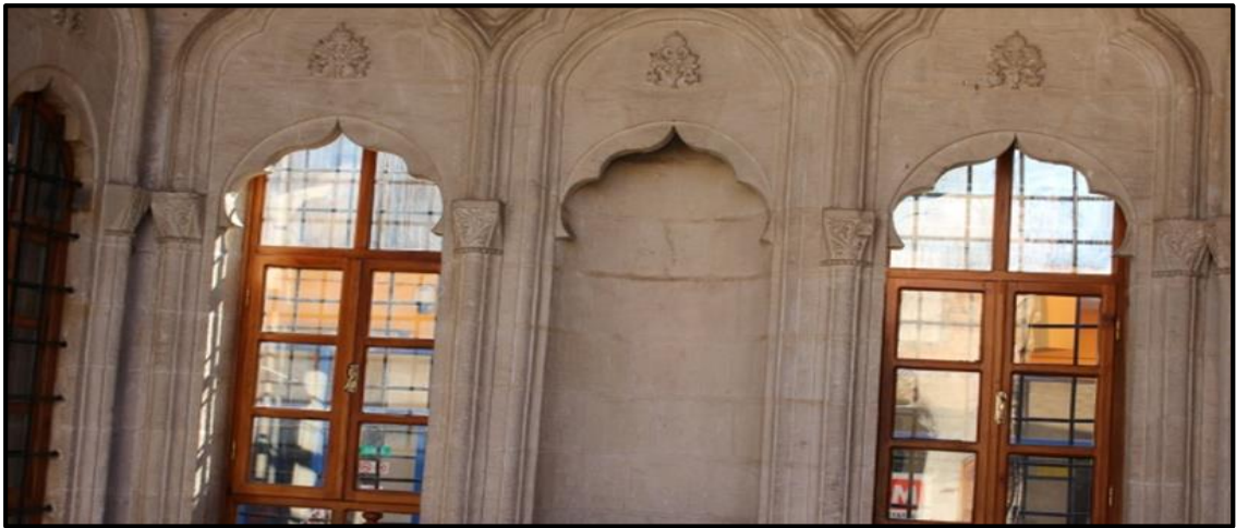
Şekil 4.41 Yazlık eyvanda havalandırma bacasının (pherik) geçtiği niş (Orjinal 2014)
