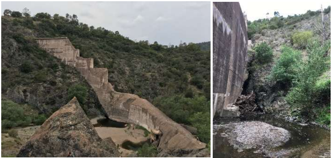
Şekil 1.1 Malpasset Barajı kalıntıları ve beton kemer gövdenin taban kısmından yukarı doğru daralarak kapanan yarık açıklık (Fotoğraflar: Yakut, 2019)
