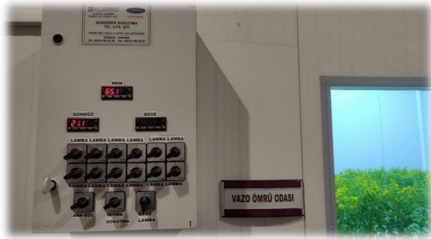
Şekil 3.9 Vazo ömrü odasında ışık, sıcaklık ve nem koşullarının kontrolünü sağlayan panodan görünüm
