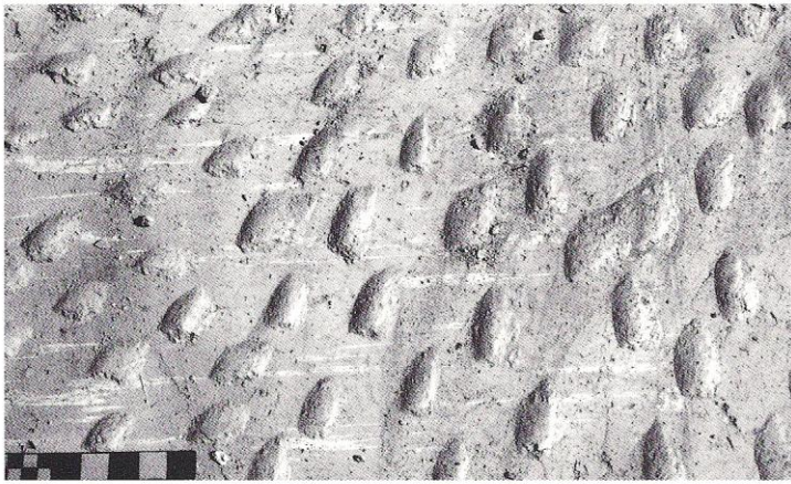
Fig. 133 : Empreinte en relief du piquetage en creux au revers de l' arriccio , pièce P26 (C13), mur est (E. Özdemir).
