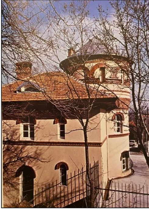
Şekil 4.24 Kuzey kapısı, onarım sonrası görünüş (Gülersoy, 1985)
