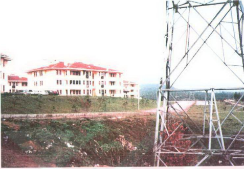
Şekil 4.6. Yerleşim alanlarındaki gerilim hattı
