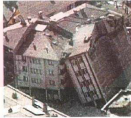
Şekil 2.17. Bitişik bina tarzının deprem anında oluşturduğu zarar
