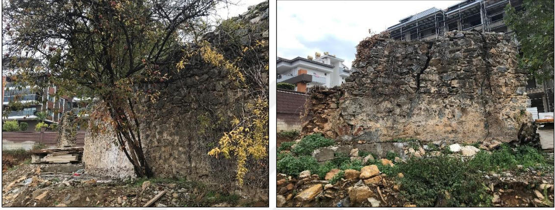
Şekil 4.42 Sugözü Av Köşkü kuşatma duvarları (Orijinal 2022)
