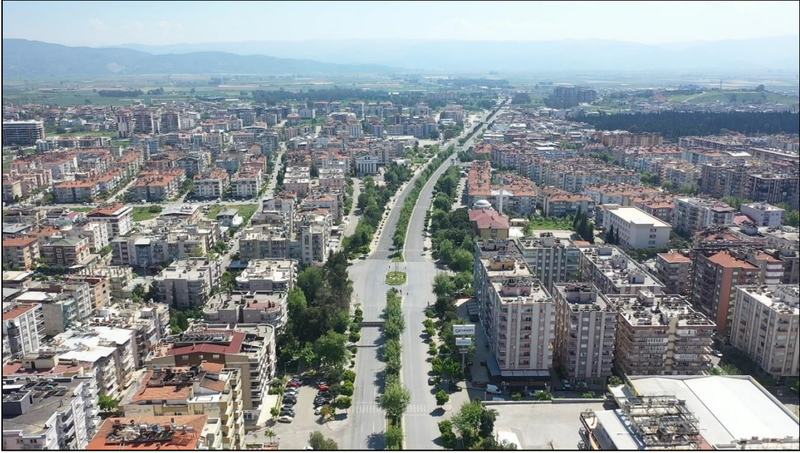
Fotoğraf 3. Aydın şehrinin genel görünüşü: Muğla Bulvarı (güney yönünde)
