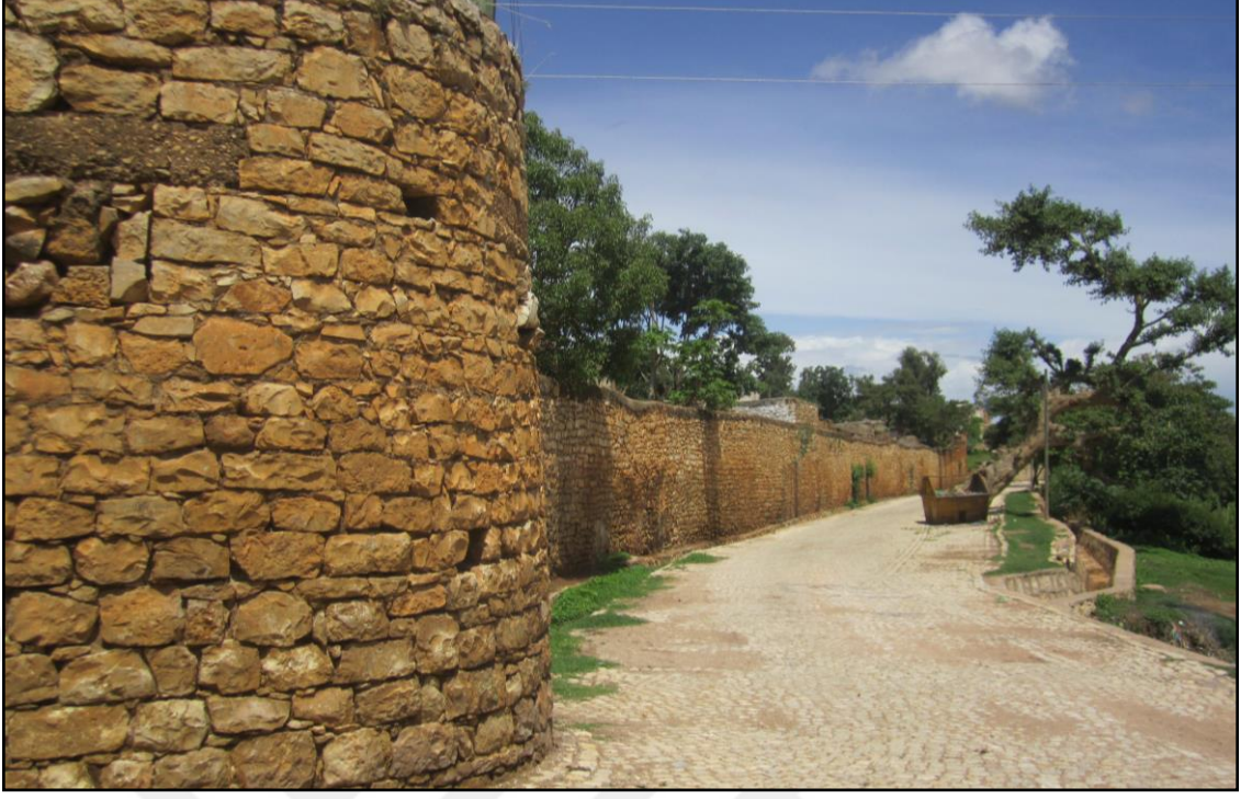
Şekil 4.7 kentin güney sınırındaki duvar (Orijinal 2015)
