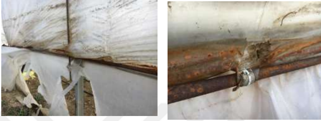
Şekil 4.8 PE örtü oksitlenme etkisi (Çubuk ilçesi 1 nolu sera)
