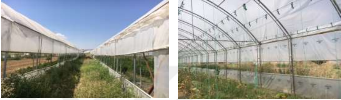
Şekil 4.10 Seralarda doğal havalandırma uygulaması (Çubuk ilçesi 1 nolu sera)
