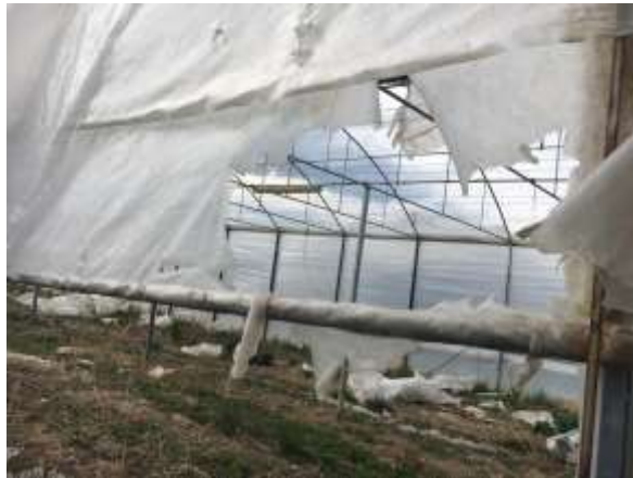
Şekil 4.7 Donma etkisi kırılmalık özelliği (Çubuk ilçesi 1 nolu sera)
