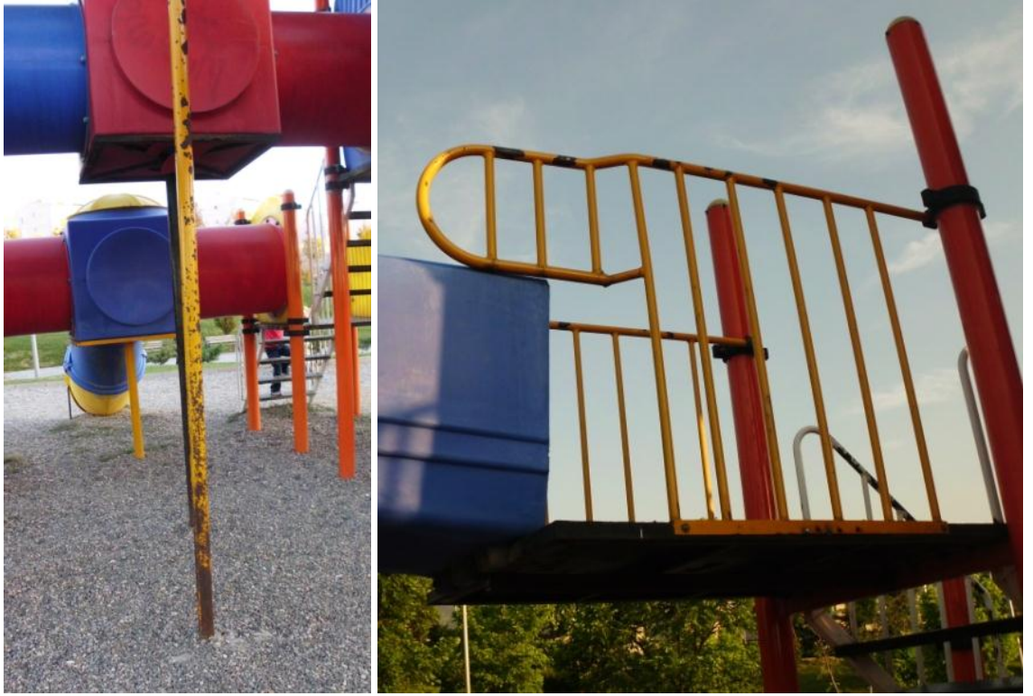
Şekil 4.19 Ali Dinçer Parkı'ndaki paslanmış metal parça detayları
