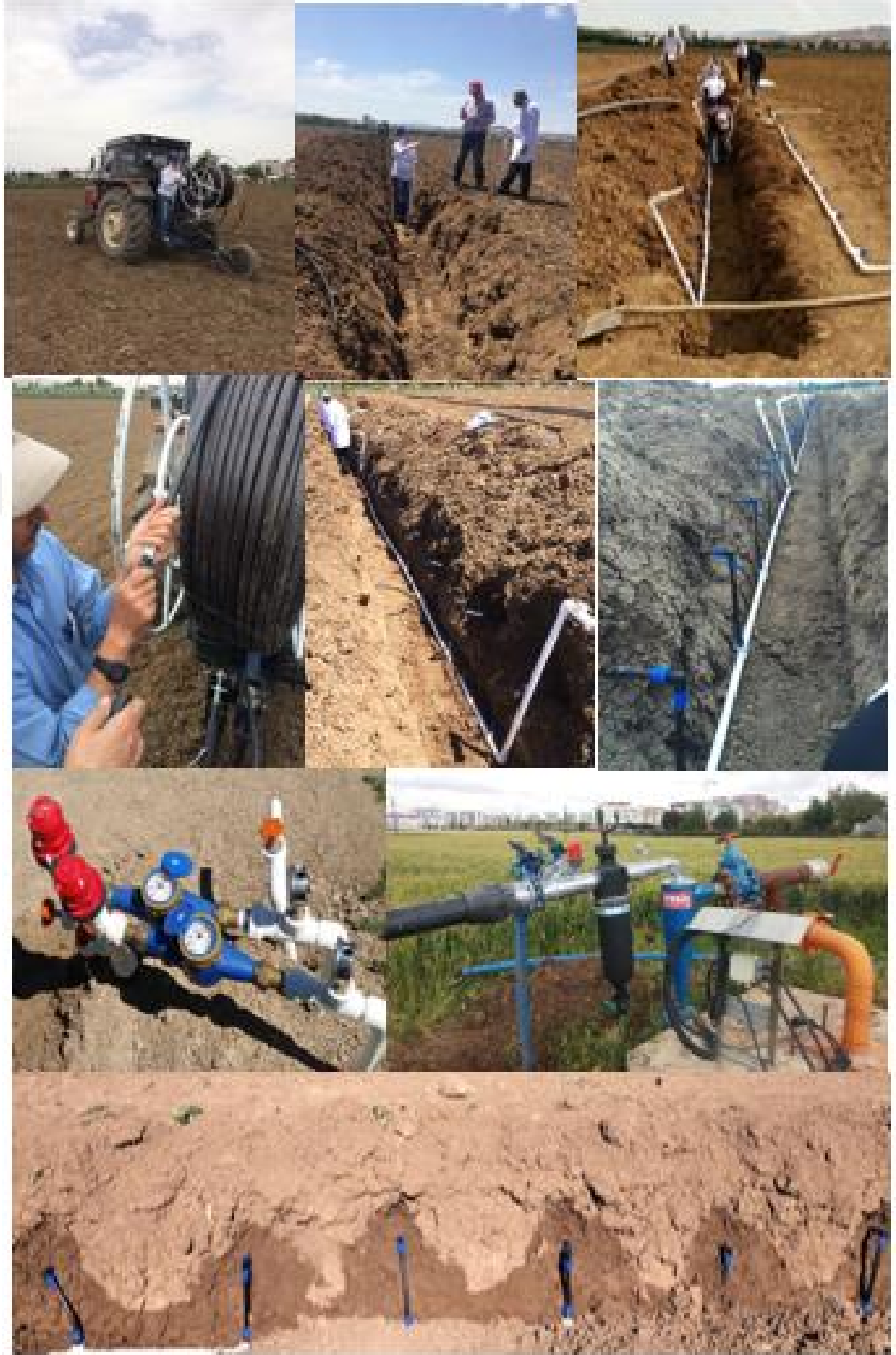
Şekil 3.9 Sulama sisteminin araziye kurulumu
