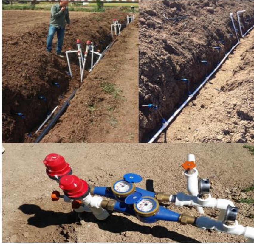
Şekil 3.6 Manifold giriş ve çıkış hatları
