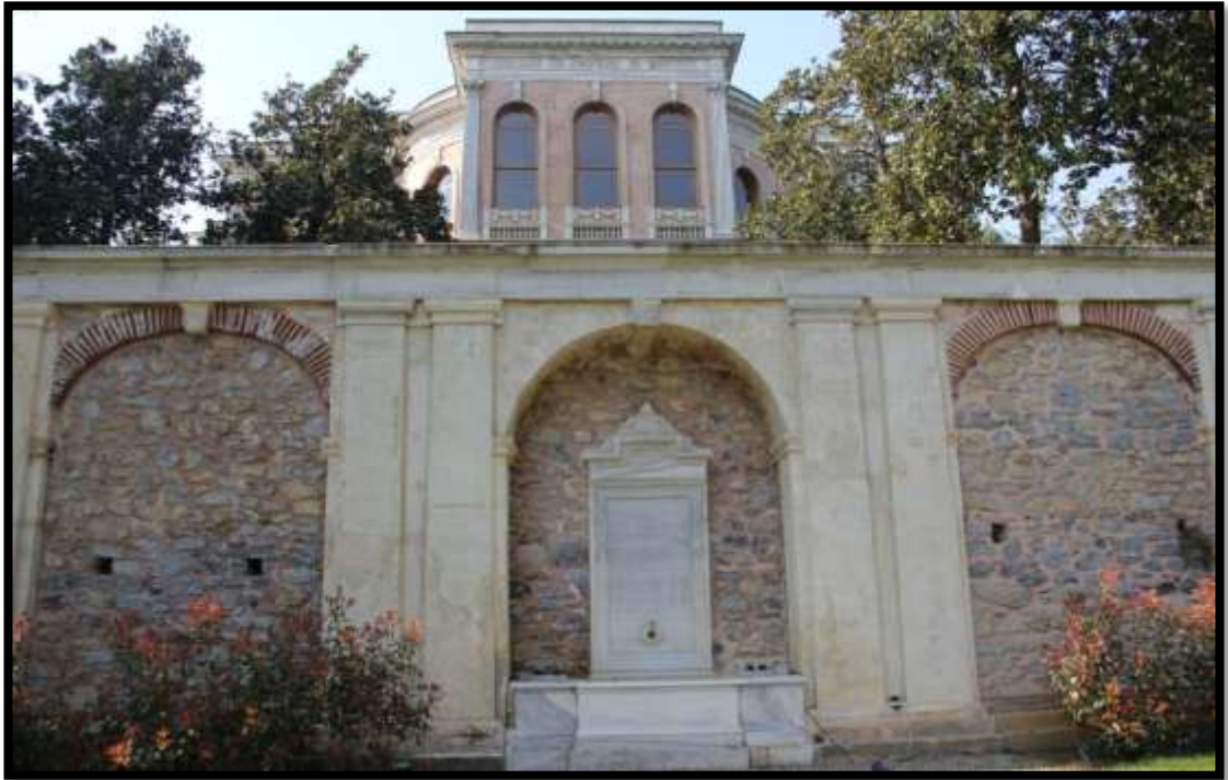
Şekil 4.17 II. set güney cephesinin duvarında bulunan çeşme (Orijinal 2014)
