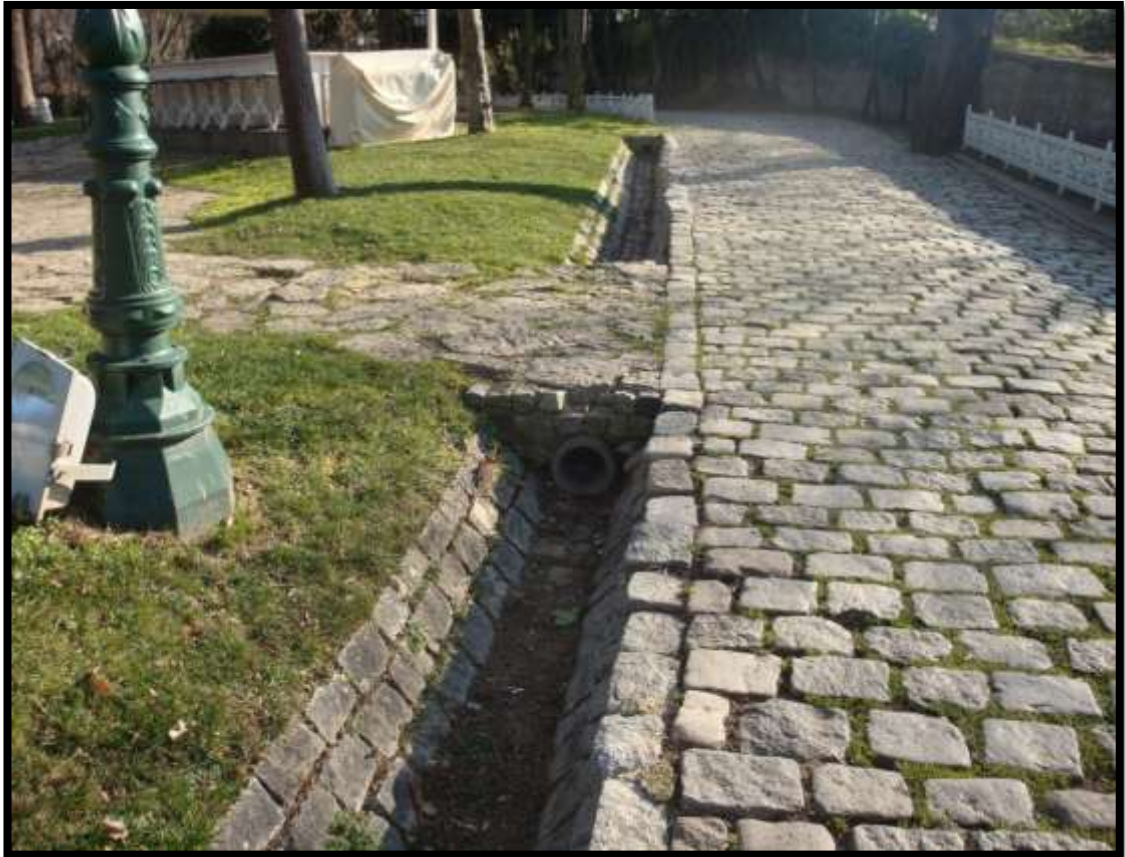
Şekil 2.43 Hidiv Kasrı drenaj kanalları (Orijinal 2014)
