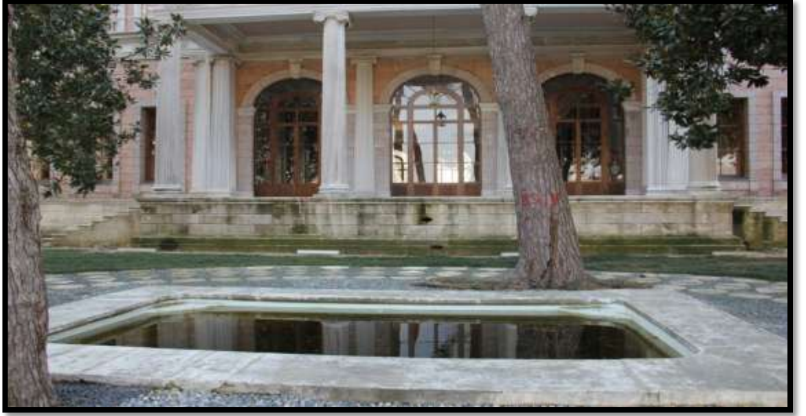
Şekil 4.12 Kasrın kuzey cephesindeki dikdörtgen havuz (Orijinal 2014)
