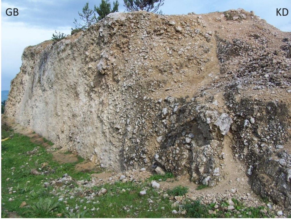
Şekil 3.16 GY-1 gözlem alanında (Bolu bölgesi) hasar zonu kesiminde yer alan breşlerin arazi görünümü (Konum için şekil 3.11'e bakınız)
